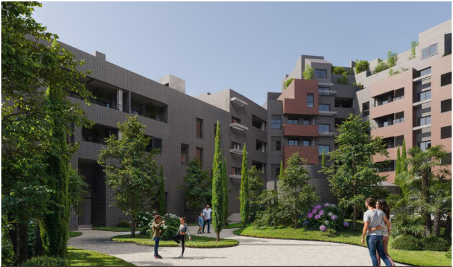
EDIFICIO DE 103 VIVIENDAS Y GARAJE. CALLE SAN ANTÓN, VALDEMORO (MADRID)
